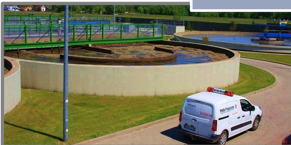
Oczyszczalnia ścieków w Piasecznie
