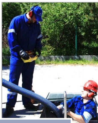
Ekipa pogotowia kanalizacyjnego
