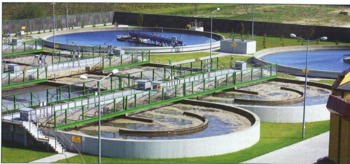
Fot. 1. Komory osadu czynnego oraz osadniki wtórne radialne
