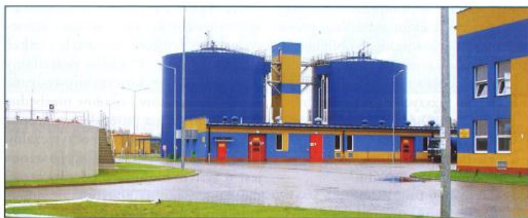
Fot. 2. Wydzielone zamknięte komory fermentacyjne
