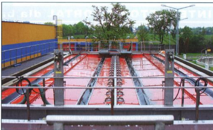
Fot. 4. Piaskownik przedmuchiwany poziomy podłużny
