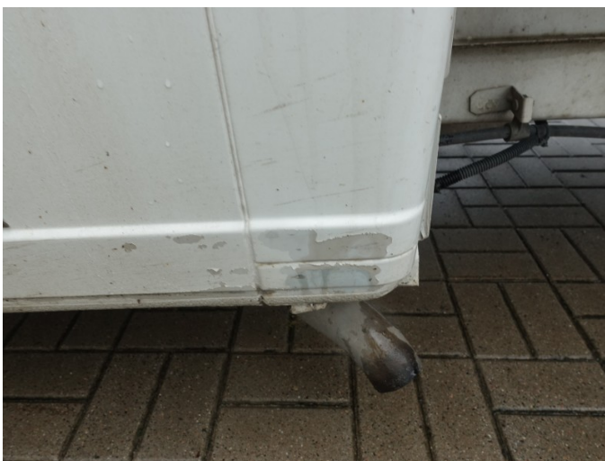
Ściana lewa kabiny
